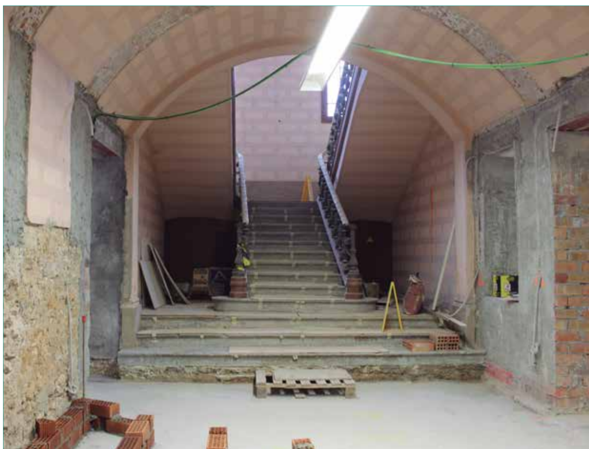
Històrica entrada principal de l'edifici, ara en obres. ✦ LA FURA
