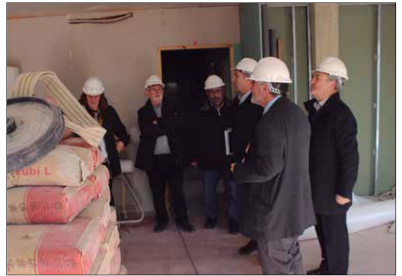
L'alcalde i dos regidors, visitant les obres de l'edifici dilluns. ✱ LA FURA
