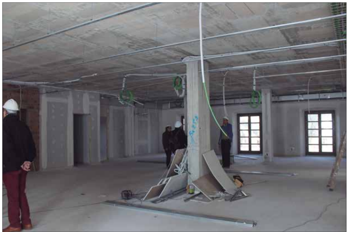
El regidor de projectes i Obres, Joan Giribet, va visitar dimarts les obres. ✳ LA FURA
