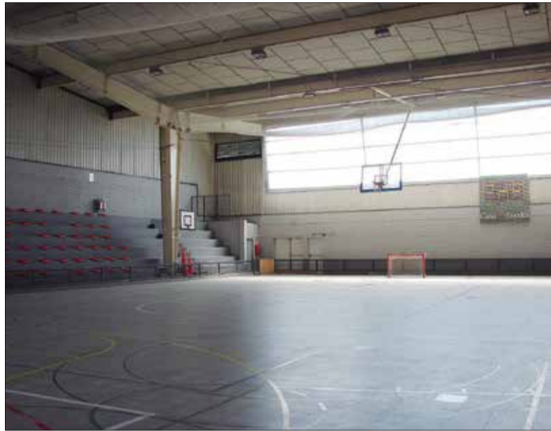
Estat actual de la pista poliesportiva. * AJUNTAMENT DELS MONJOS
