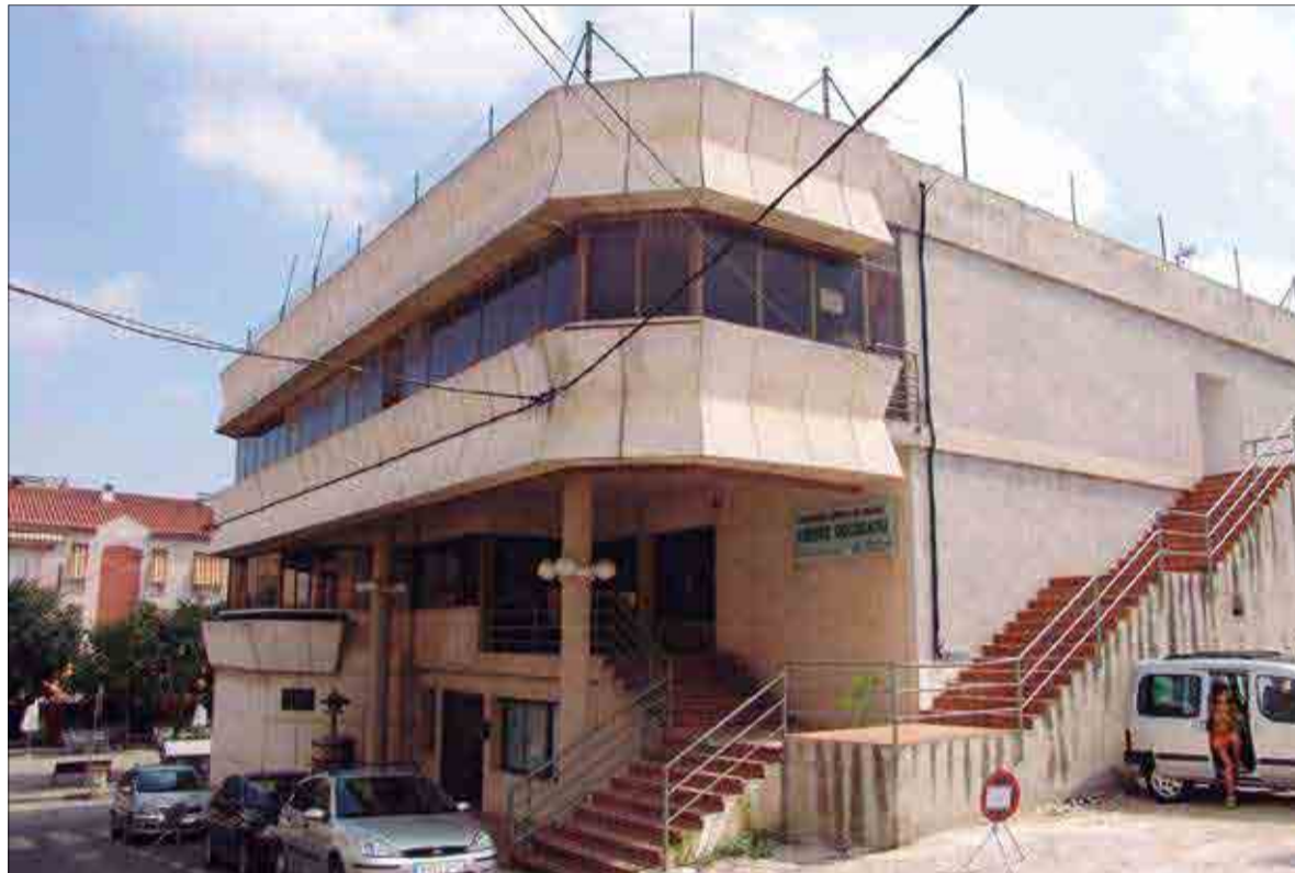
La nova biblioteca s'ubicarà a l'antic edifici d'El Sindicat. ✖ AJUNTAMENT DE CALAFELL
