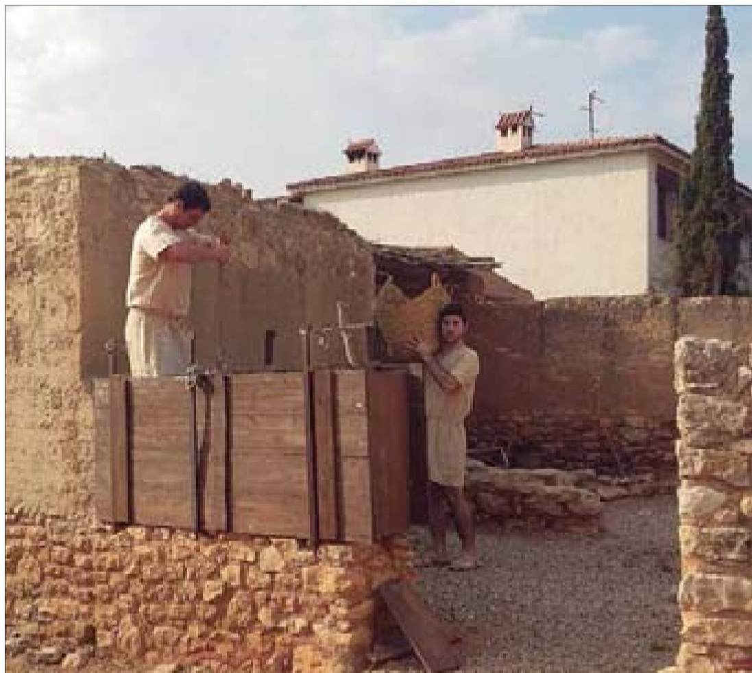
Una de les tècniques que empraven els ibers per construir les parets era l'encofrat. ✦ LA FURA
