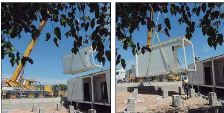
Els mòduls prefabricats permetran al centre tenir quatre aules més.
