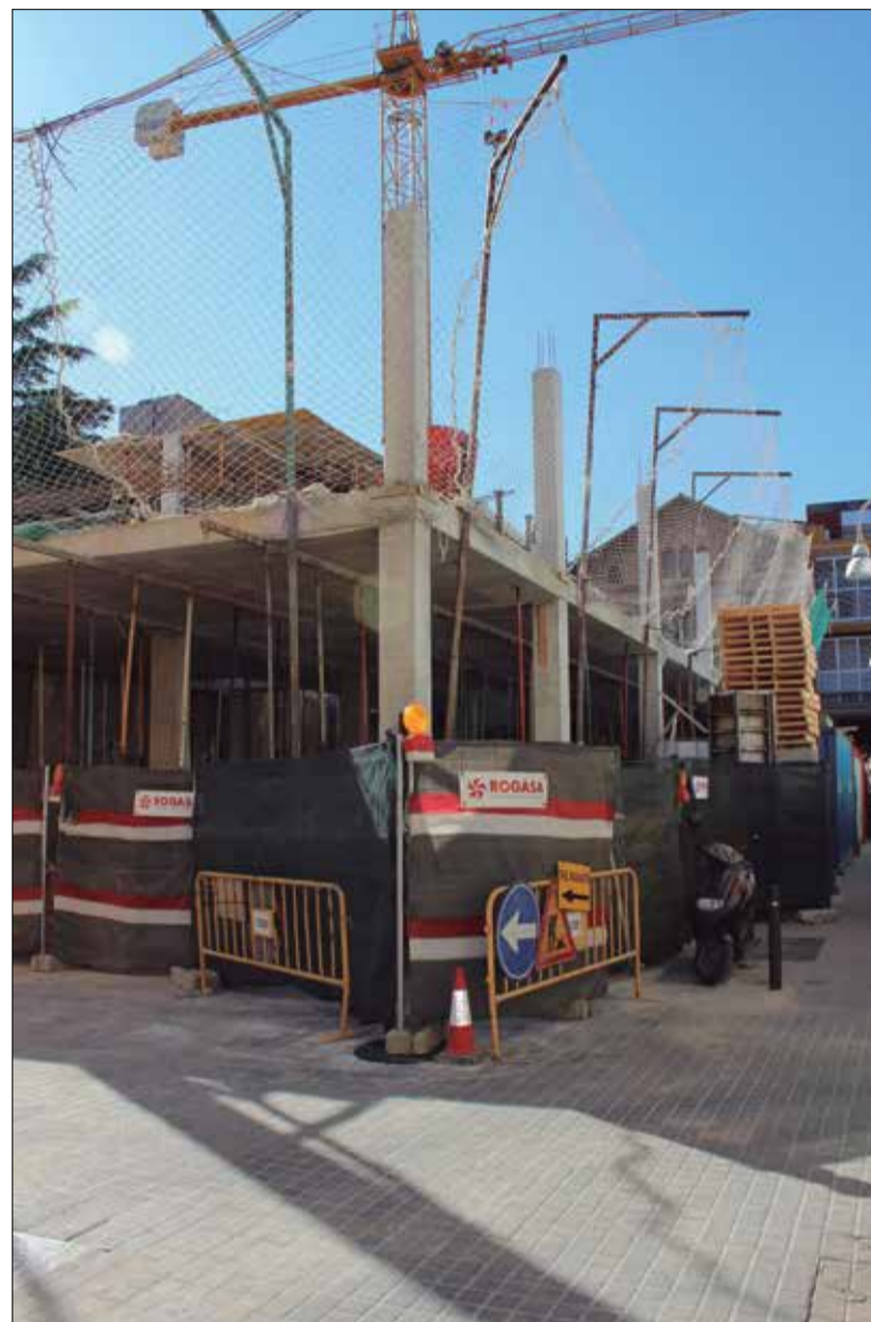
A l'antic solar del cinema Victòria s'estan construint 12 pisos per a gent gran.
