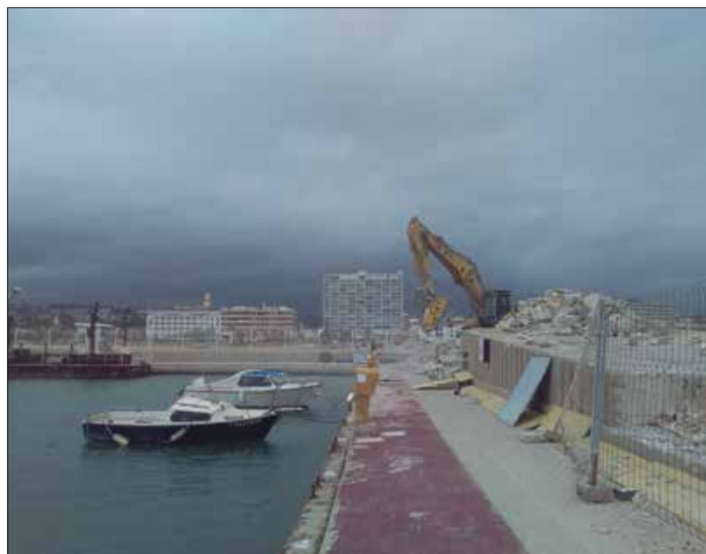
Una excavadora enderrocant el vial del port, davant la dàrsena. ✱ LA FURA
