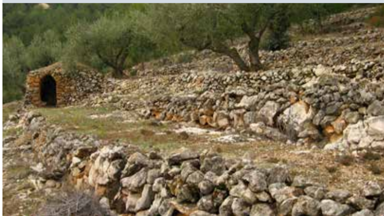
Barraca i marges que formen terrasses per salvar el desnivell.
