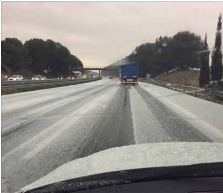
L'autopista, entre Lavern i la Granada, va quedar blanca. ✱ CARLES GALA
