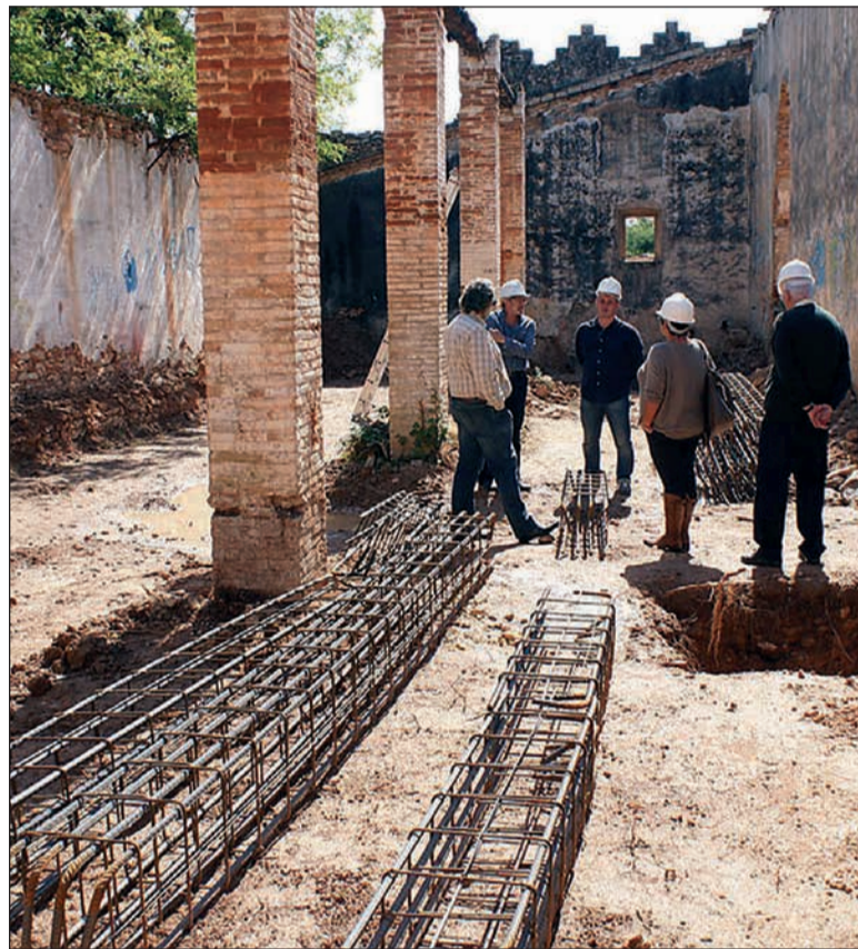
Les obres es troben actualment en la fase d'aixecar les estructures
