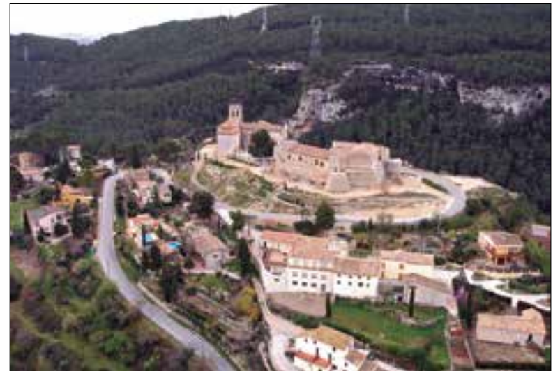
Vista aèria del sector de Sa Roca. ✱ AJUNTAMENT DE SANT MARTÍ
