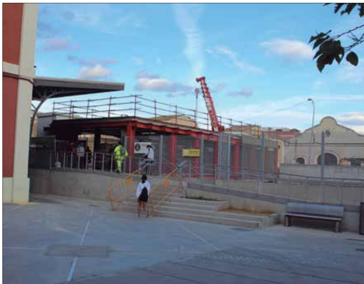
Les obres del tercer fil coincideixen amb la remodelació de l'estació de Vilafranca. ✱ LA FURA
