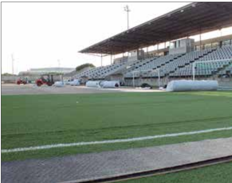
Les obres per substituir la gespa avancen a bon ritme. ✦ LA FURA
