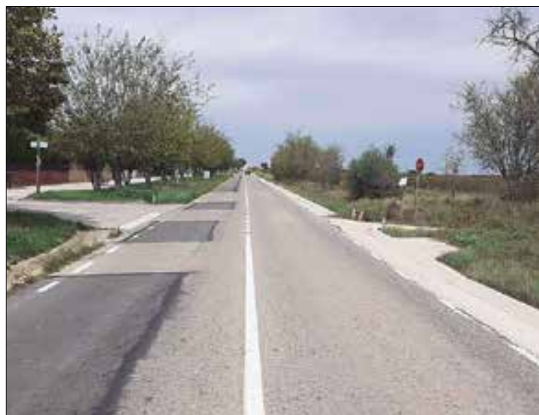
Amb l'obra, la carretera guanyarà en seguretat. ✦ DIPUTACIÓ
