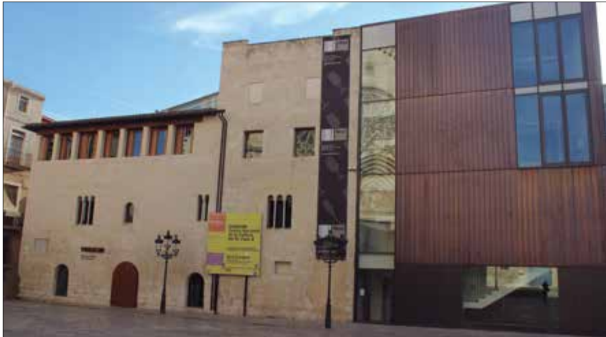
Façana del Vinseum, en plena fase de transformació. ✦ LA FURA
