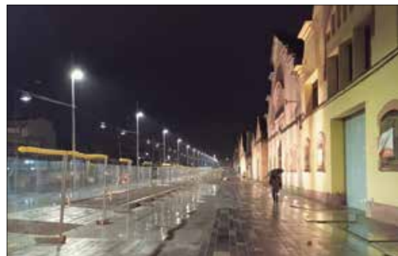
La nova il·luminació consta de 77 punts de llum aèris i 22 integrats al terra.
