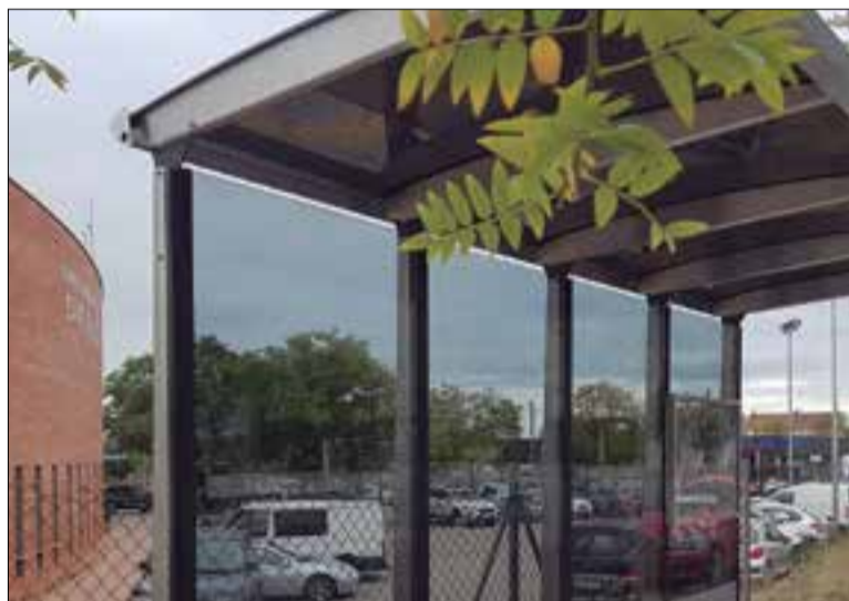
Instal·lar noves marquesines és un dels projectes a executar. ✦ AJUNTAMENT
