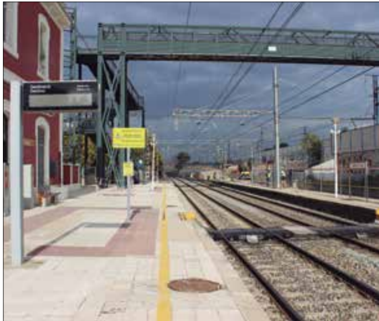
Operaris treballant a l'estació, amb una única andana en servei. ✱ LA FURA
