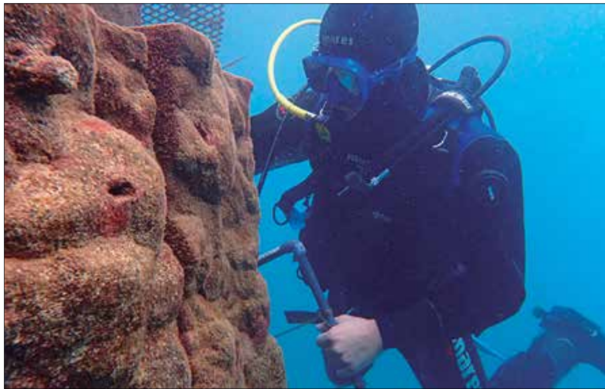
Un operari col·locant una de les estructures de regeneració marina impreses en 3D. ✖ UPC
