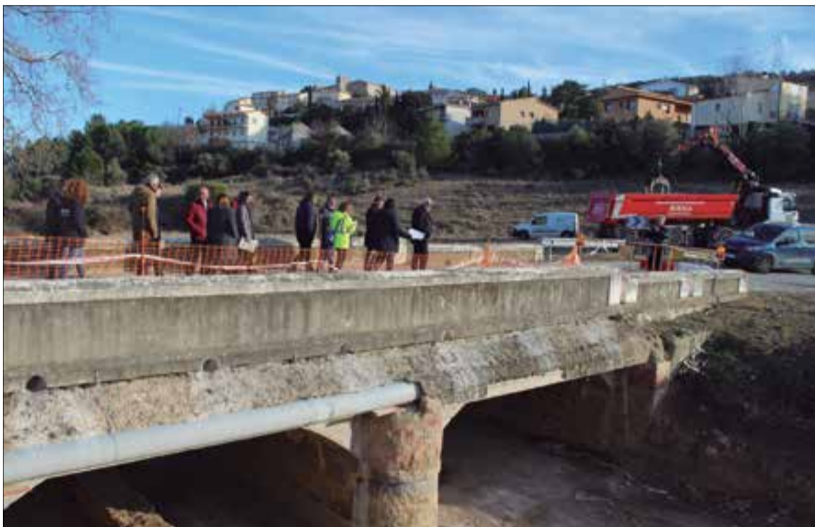
Autoritats Locals i de l'ens provincial, fent dimarts una visita a les obres en el tram del pont, que cal ampliar per tal que hi pugui passar l'itinerari a peu. ✱ LA FURA
