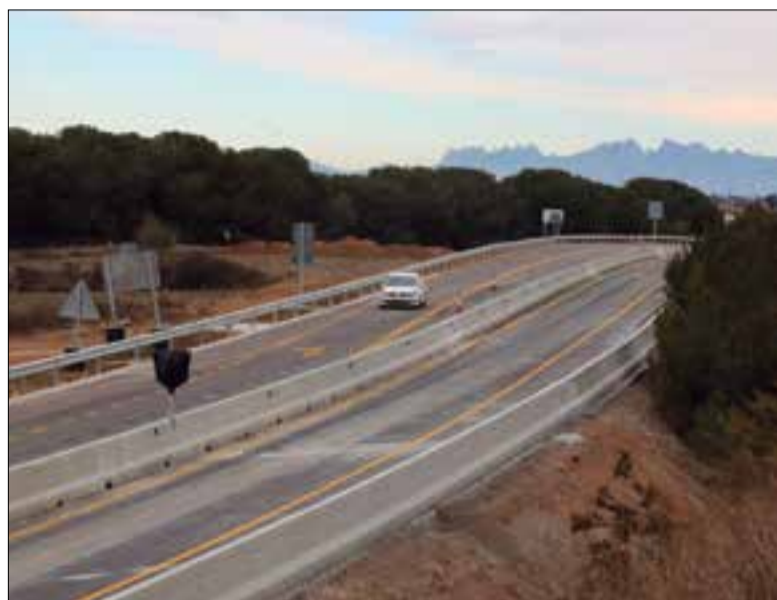
Obres a la C-15. ✱ ACN - GEMMA SÁNCHEZ
