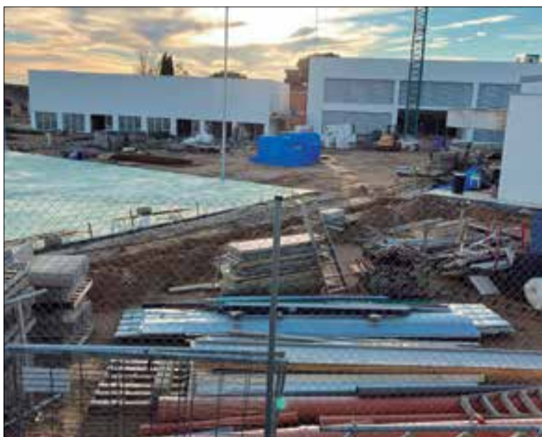
Les obres de l'escola nova estan aturades des de fa cinc mesos.
