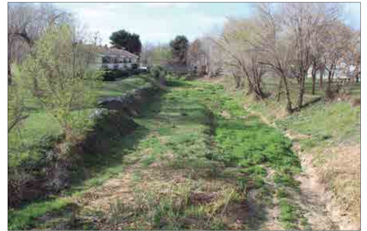
L'últim gran desbordament va ser el juny del 2018 i va afectar el pas sota la via de la Ronda Europa. ✪ LA FURA
