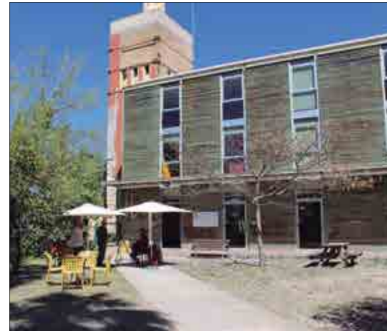
L'alberg estarà tancat el darrer trimestre de l'any per fer les obres. ✱ LA FURA
