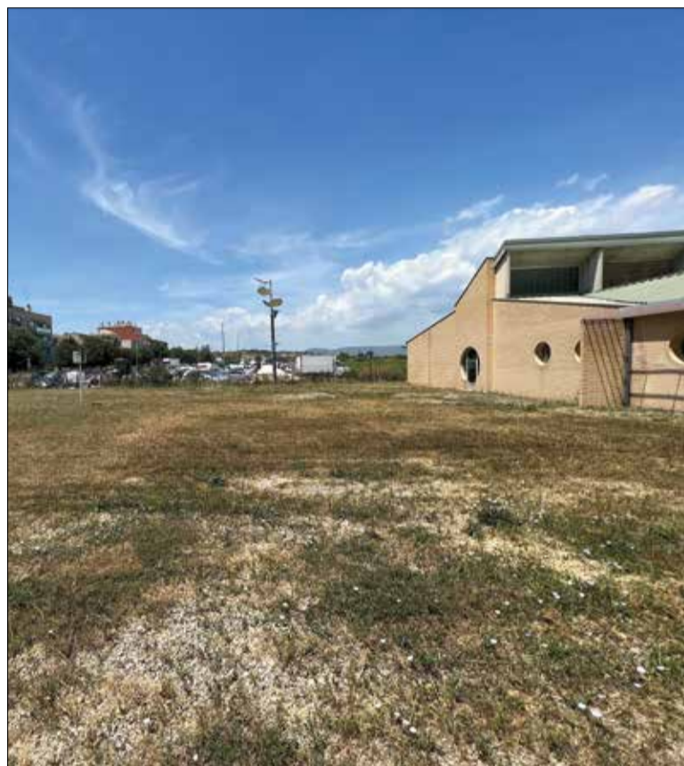
El nou bloc tindrà 1.700 m 2 i podrà atendre 30 persones per torn. * CSAPG
