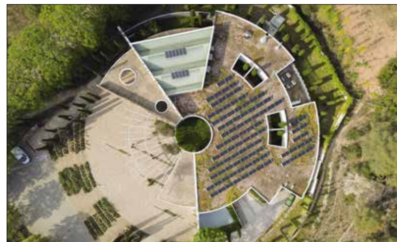
Coberta del tanatori de Sitges, amb les plaques instal·lades.
