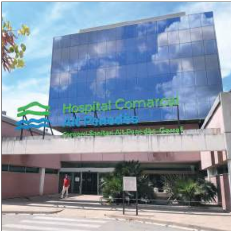
El servei Digestiu duplica l'espai i el de Rehabilitació creix un 30%. ✦ LA FURA
