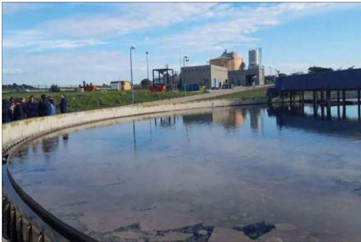
El problema principal és que les canonades que recullen les aigües residuals es troben en mal estat. ✱ LA FURA
