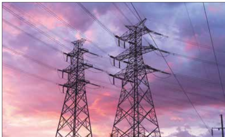
Imatge d'arxiu d'una línia d'alta tensió. ✱ ADOBESTOCK
