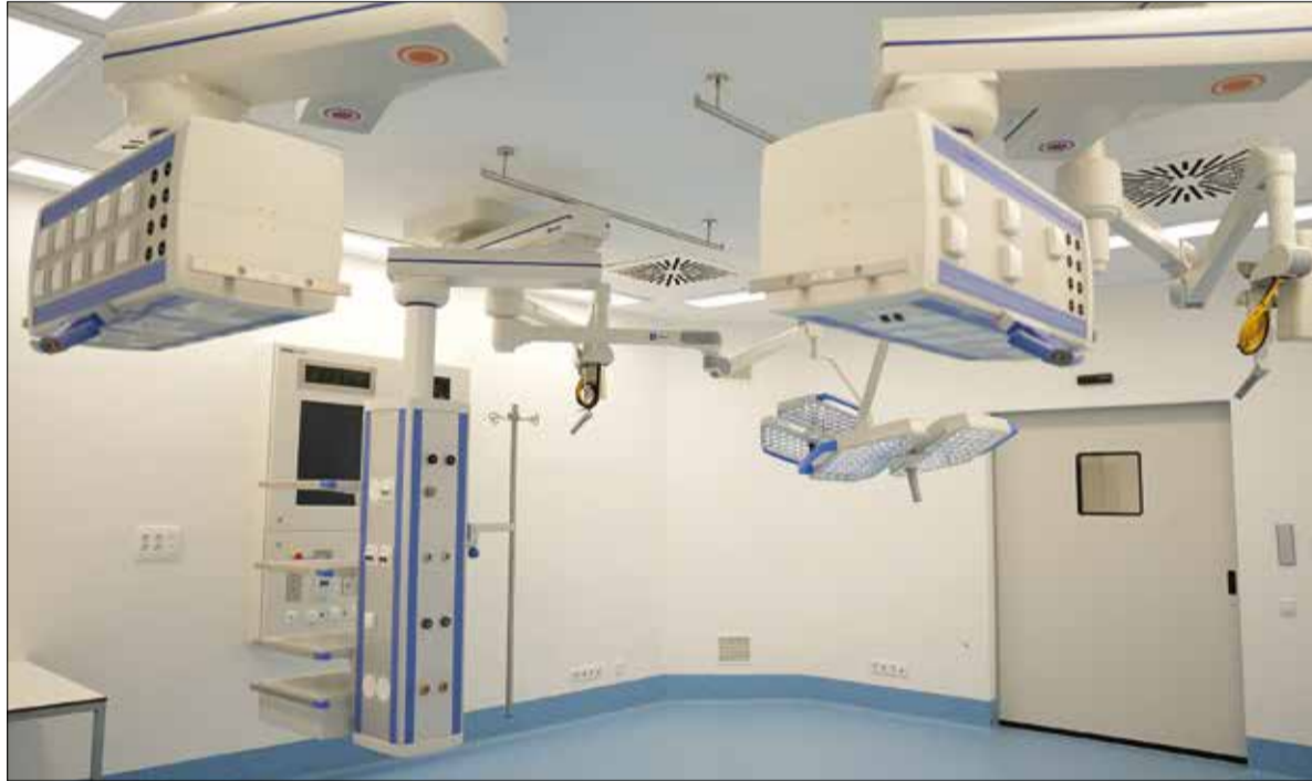
El nou bloc quirúrgic de l'Hospital Residència Sant Camil. ✦ CONSORCI
