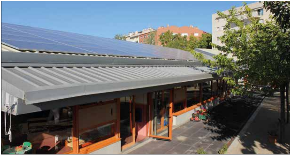
Plaques solars esteses al llarg de tota la coberta de la llar d'infants municipal El Parquet. ✱ LA FURA
