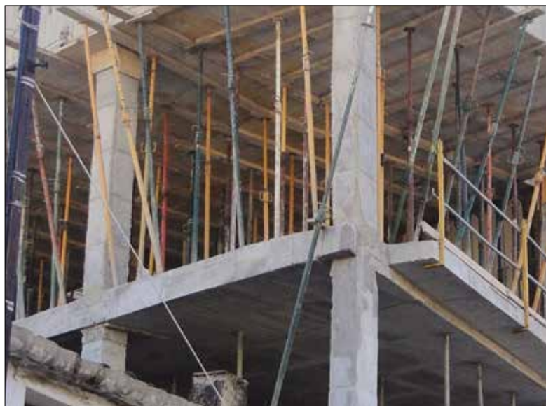
Habitatge en obres al Vendrell. ✱ LA FURA
