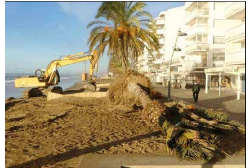
Una de les palmeres que s'ha retirat. ✱ AJUNTAMENT DE CALAFELL
