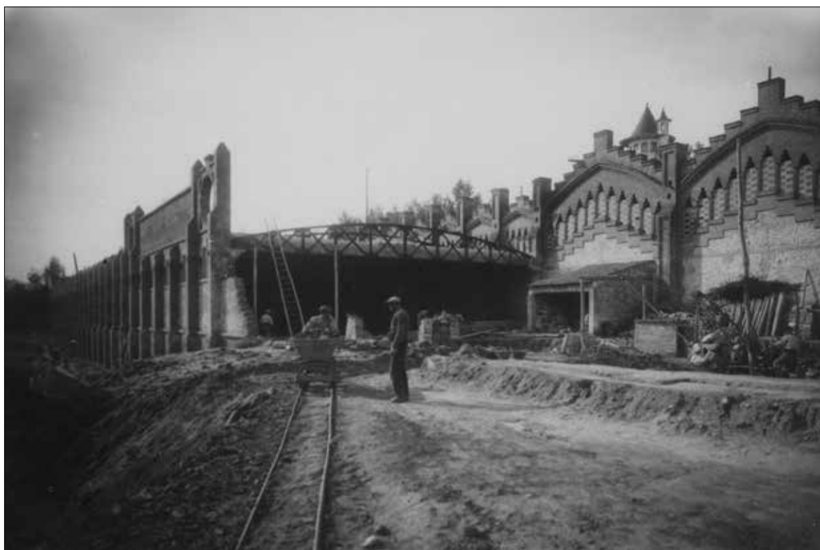
Imatge de les obres de construcció del celler de Codorniu. ✖ CODORNIU
