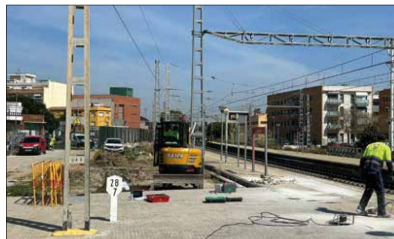
Les obres a l'estació del Vendrell. ✖ RENFE
