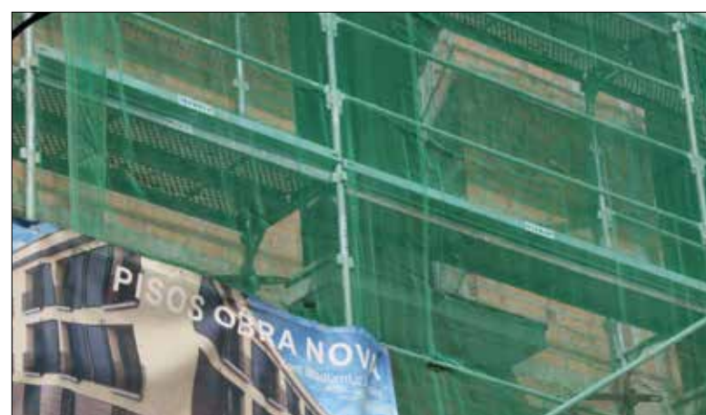
Construcció d'un bloc de pisos a Sant Sadurní. ✨ ACN / GEMMA SÁNCHEZ
