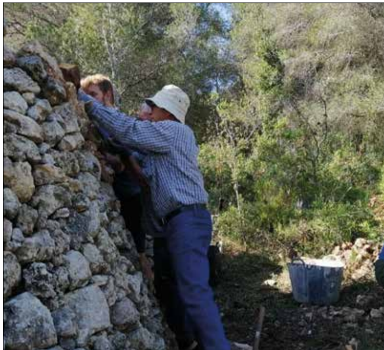
Reconstrucció d'una barraca de pedra seca. * AMICS DE LA PEDRA SECA
