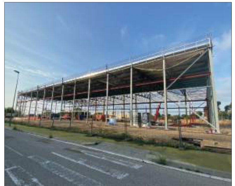
Les obres s'allargaran fins a finals de l'any que ve. ✦ LA FURA
