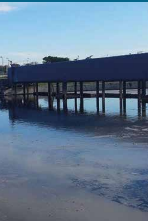
La depuradora de Santa Oliva ✖ LA FURA
