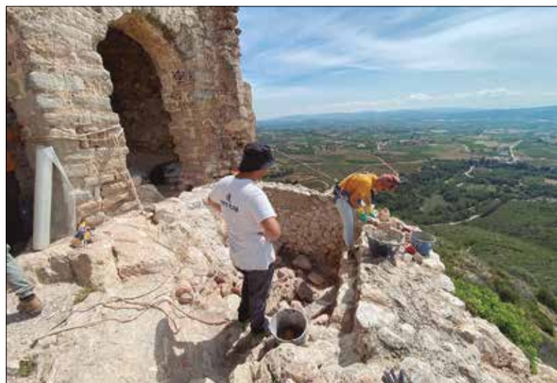
Les excavacions s'han fet en el marc de les obres de restauració. ✱ CEDIDA
