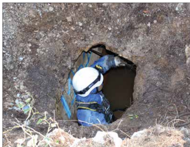
Un operari treballant a la mina. ✱ LA FURA
