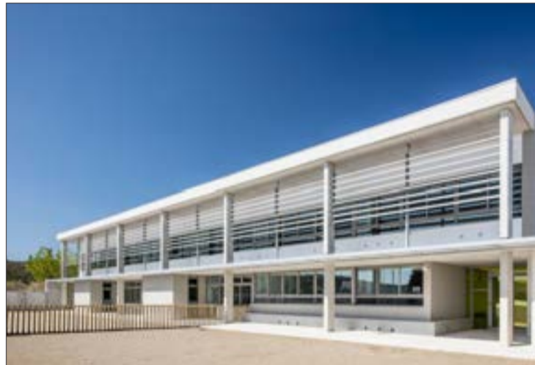
Una avaria en algun punt de la instal·lació contamina l'aigua de l'escola.
