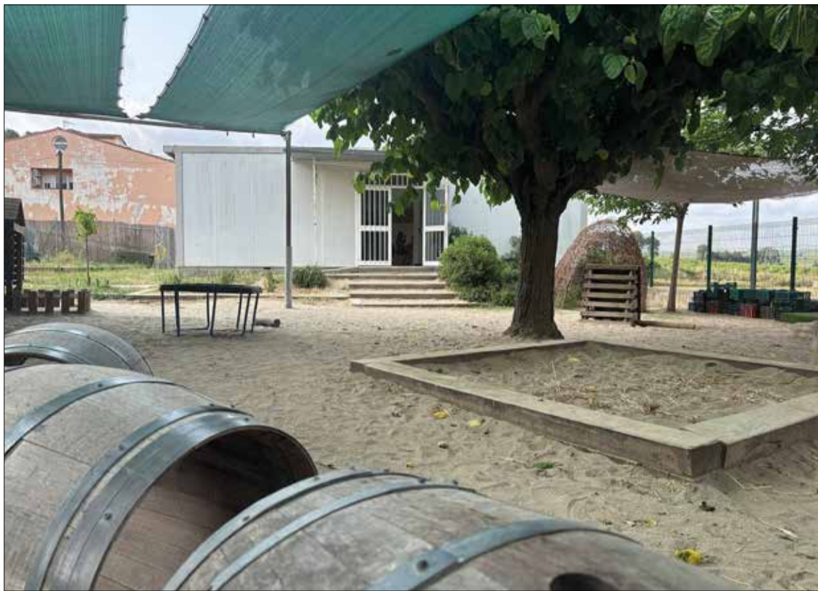
El mòdul prefabricat ubicat a l'escola El Serral. ✱ LA FURA
