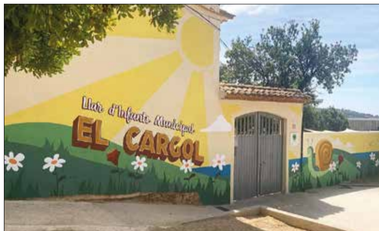
El sistema de climatització es va espatllar a finals de maig. ✦ AJUNTAMENT
