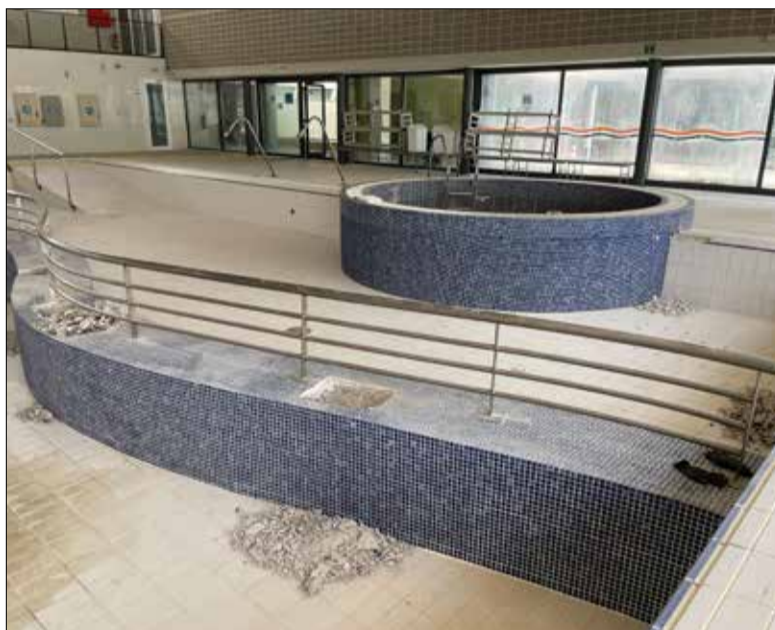
Les obres tenen un cost aproximat de 3,4 milions d'euros. ✪ AJUNTAMENT
