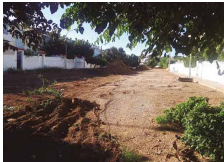
El torrent dels Aragalls, en obres. ✱ LA FURA
