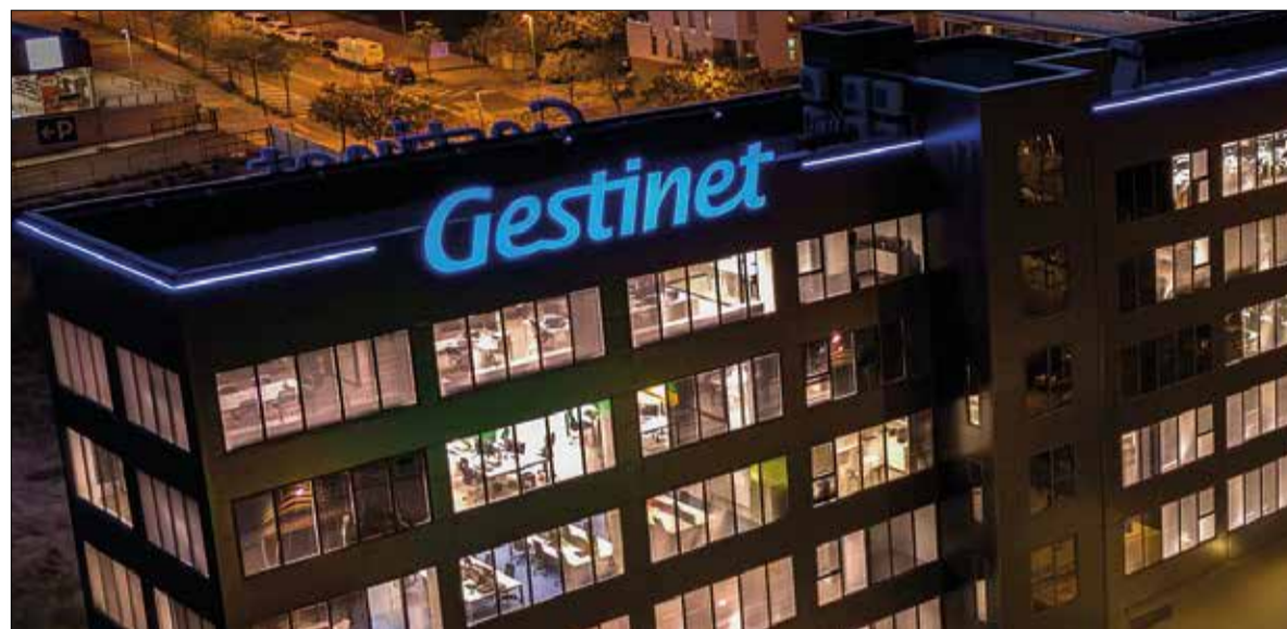
Instal·lacions de la seu central de Gestinet, ubicades a l'avinguda Ronda de Mar de Vilafranca.
