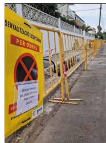
Les obres han començat al carrer Josep Llimona, a Ribes.
