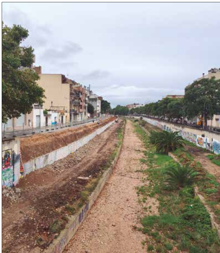
Obres a la riera de la Bisbal a l'altura del Vendrell. ✱ LA FURA
