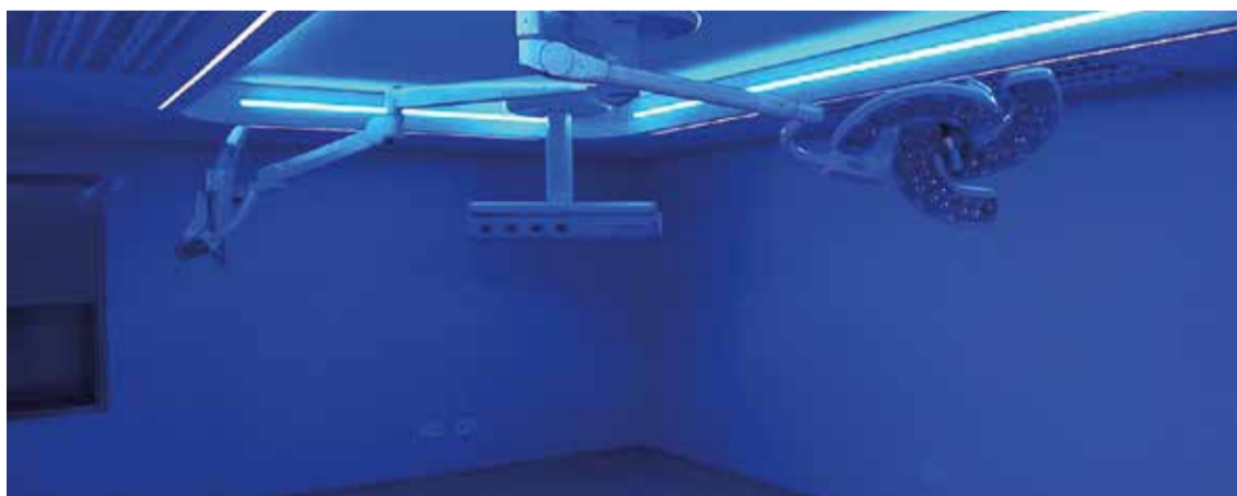
Nou bloc quirúrgic de l'Hospital Sant Antoni Abat de Vilanova.
