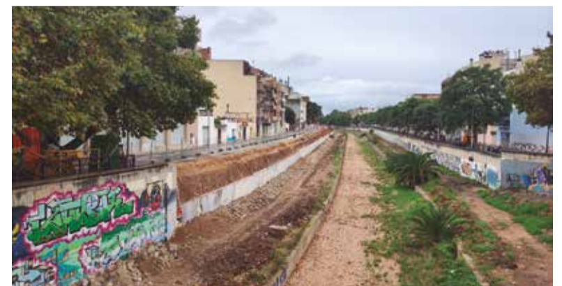
Les obres de la riera estan a punt d'acabar la primera fase. ✱ LA FURA
