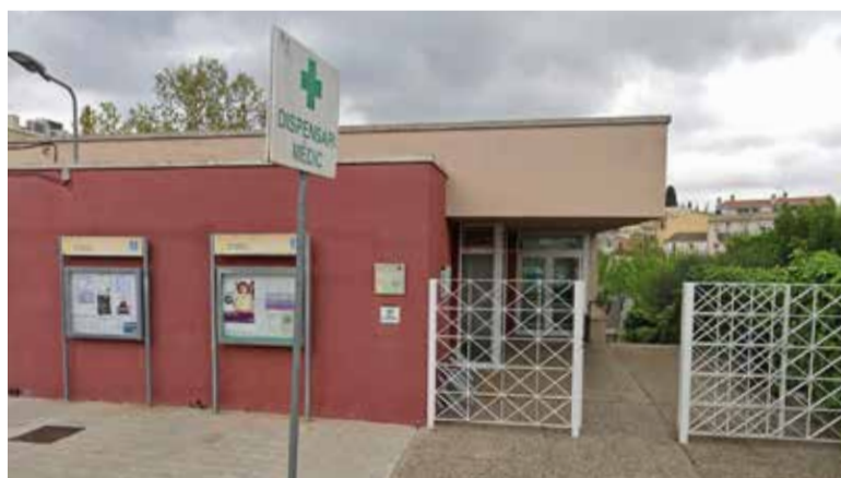
El 30 de desembre un camió va arrencar el cablejat de fibra òptica. ✖ LA FURA
