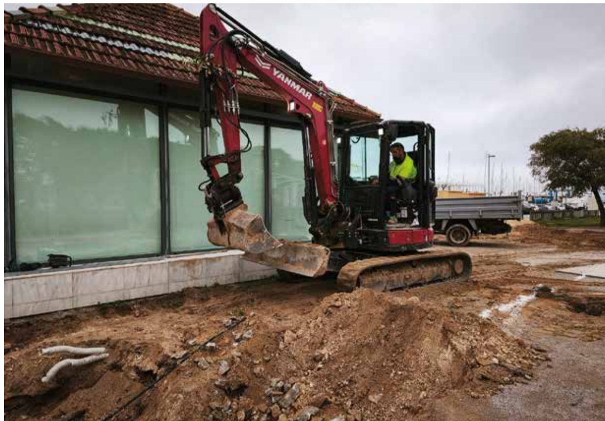
La voluntat del govern és que les obres estiguin acabades abans de l'estiu. ✖ AJUNTAMENT
