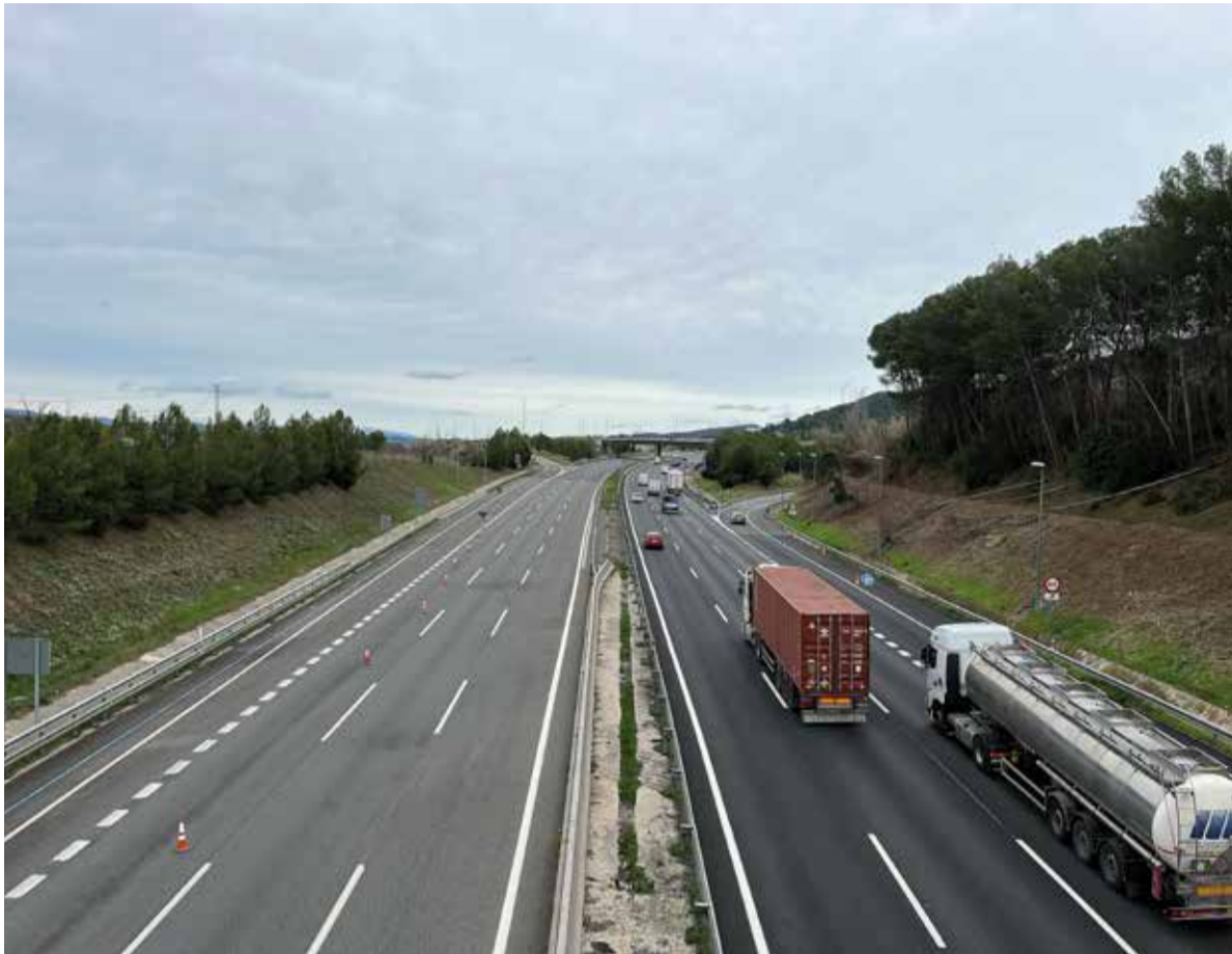
L'autopista AP-7, tallada en sentit Tarragona, en el seu pas per Gelida. ✱ LA FURA
