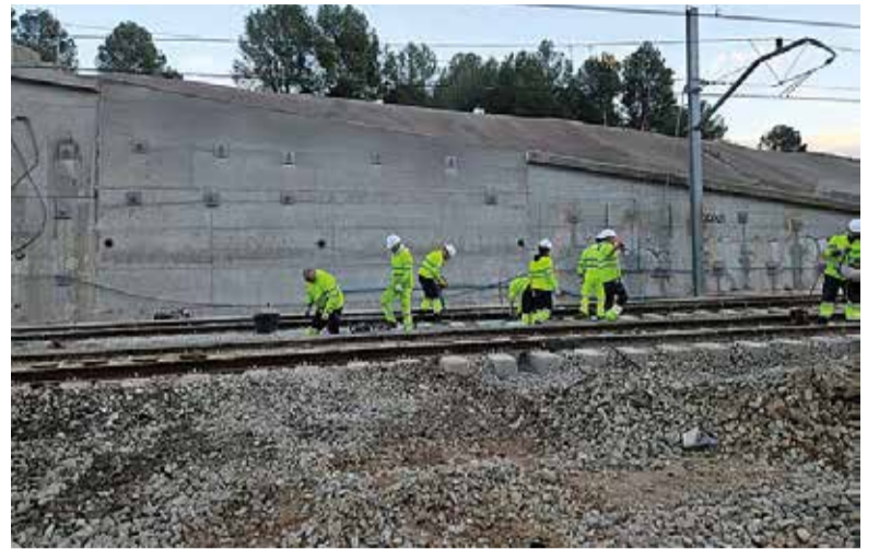
Operaris treballant en el reforç del talús de l'AP-7 esfondrat sobre les vies.
